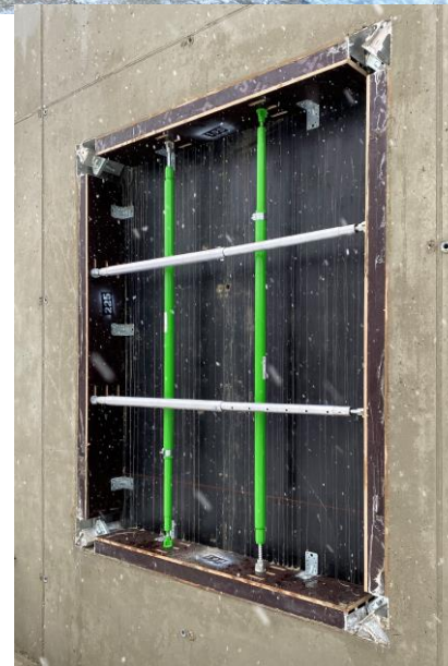
Fenster H/B 190 x 225 cm vor und nach Betonage
