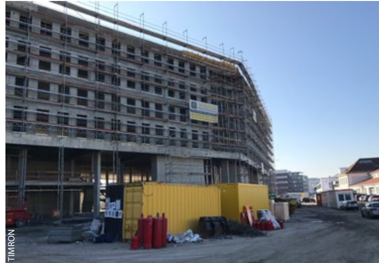
Beim Bau eines Hotels am Ortseingang von Böblingen kam die wiederverwendbare Timron Tür- und Fensterschalung zum Einsatz.
